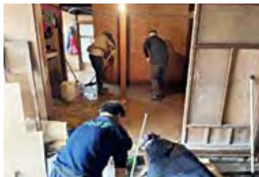
床上浸水した住宅で作業するボランティア
