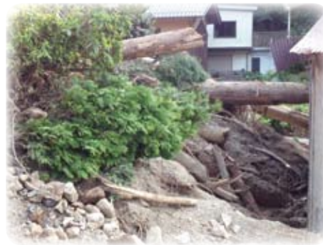
家屋に迫る土砂と流木
