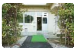
駐車場からの通路（東側出入口）
