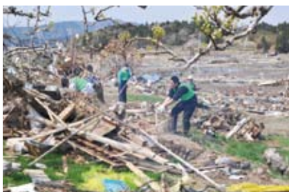
住宅地や畑地での瓦礫撤去作業
